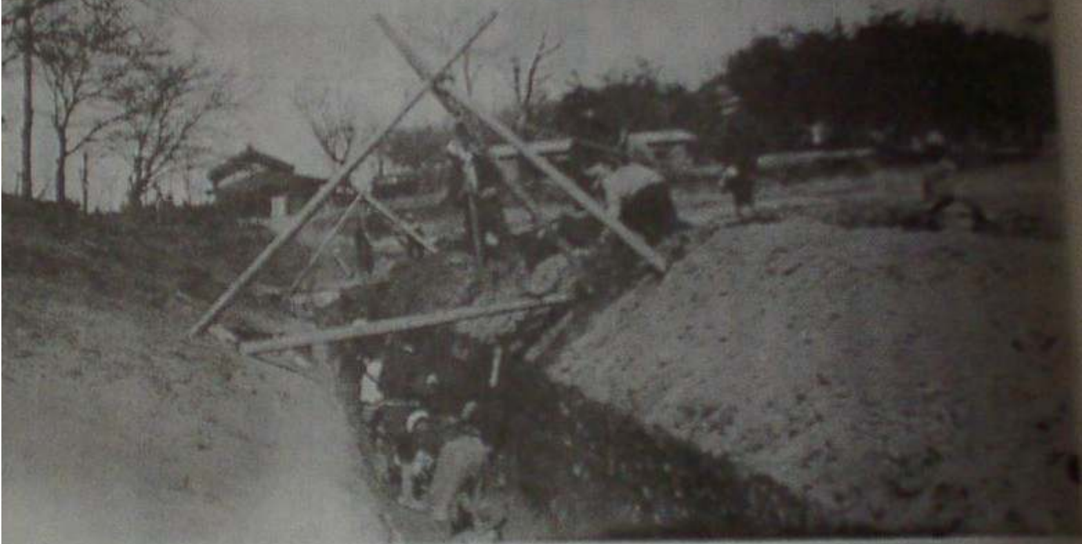
八幡沼改修工事(昭和9年完工)
